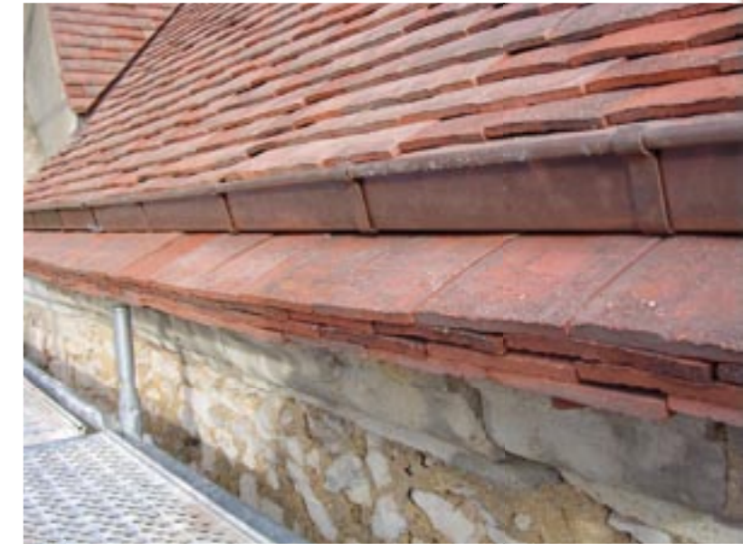
Gouttière de type lavalloise surmontant un triple rang de battellement
