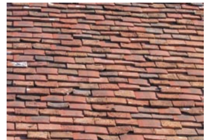
Reprise d'une couverture ancienne à l'aide de tuiles neuves
