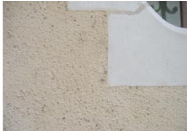
Enduit brossé lavé
