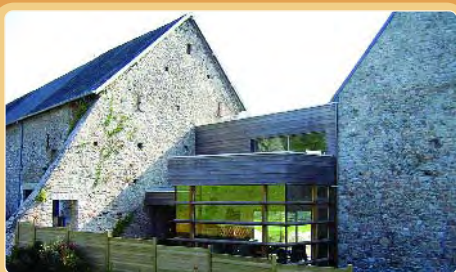
Bernard Vimond, architecte
