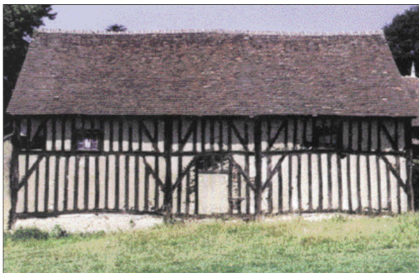
Vue façade est
